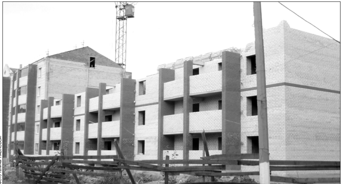
▲ Проверяют даже стройплощадки
