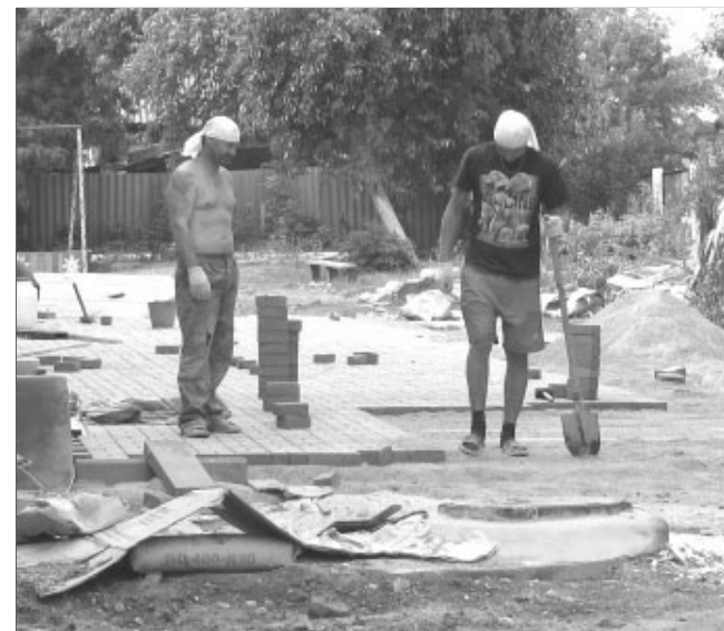
Пока студенты обеды, рабочие подсыпали площадку.
